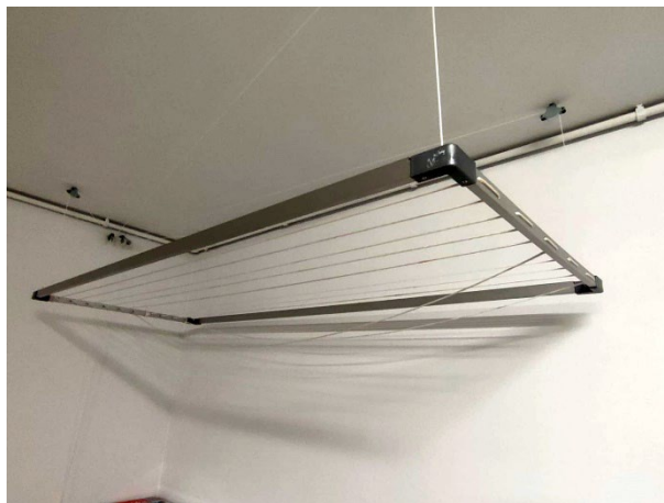
Imagen 47. Tendedero de techo
