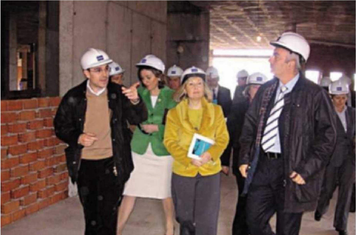
La secretaria de Estado de Servicios Sociales, Amparo Valcarce, visitó recientemente la marcha de las obras de construcción del nuevo edificio.
